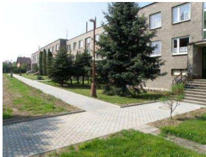
Nový chodník u bytovek
