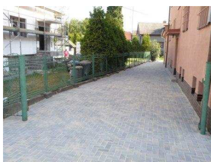
Nový vjezd k budově čp. 900
