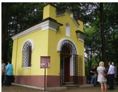
Oprava Něbrojovy kaple
