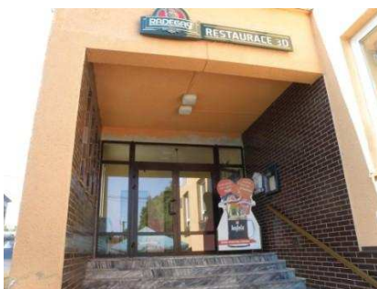
Výměna oken a dveří v Dělnickém domě
