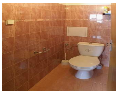
Nové rozvody vody v DPS 670
