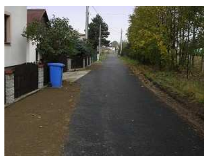
Místní komunikace Ulman - Balon
