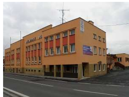
Obnova fasády Dělnického domu
