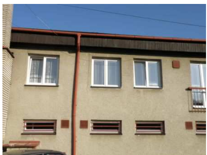
Výměna oken v budově SK
