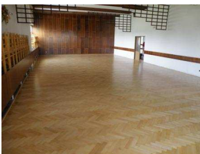
Oprava podlahy v sále Motorestu
