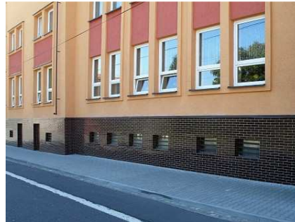
Oprava soklu Dělnického domu
