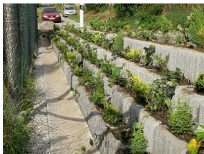
Opěrná zeď Ryšková
