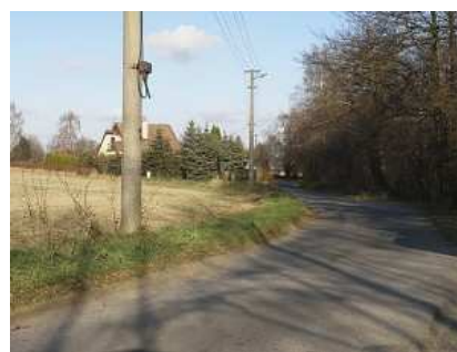
Odvodnění komunikace na Zálesí
