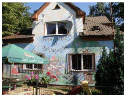
Výměna oken a dveří v restauraci Rumcajs
