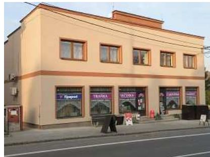
Zateplení budovy čp. 942
