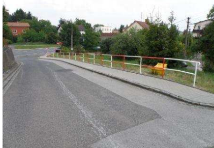
Zábradlí podél chodníku k bytovkám
