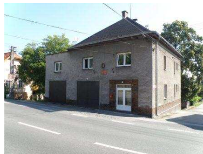
Výměna oken a dveří v hasičské zbrojnici
