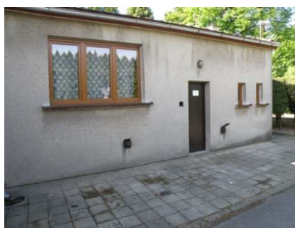
Výměna oken ve smuteční síni
