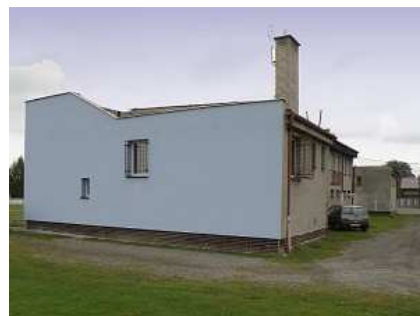
Výměna oken, zateplení budovy SK
