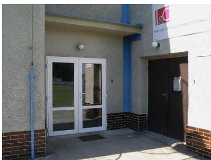
Výměna vchodových dveří SK
