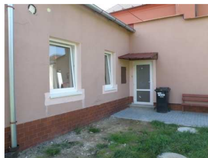
Výměna oken v budově čp. 900
