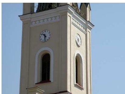
Oprava fasády věže kostela
