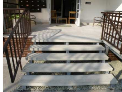
Oprava vstupu DPS čp. 670
