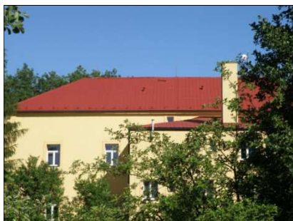
Oprava střechy MŠ Koukolná
