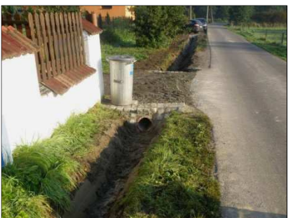
Odvodnění na Zálesí
