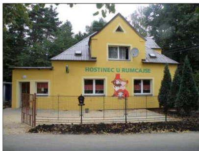
Zateplení objektu Rumcajs
