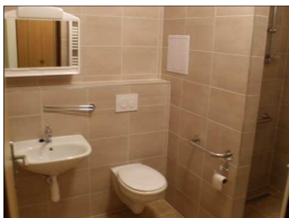
Rekonstrukce koupelen na DPS
