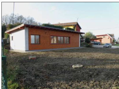
Výstavba klubovny zahrádkářů
