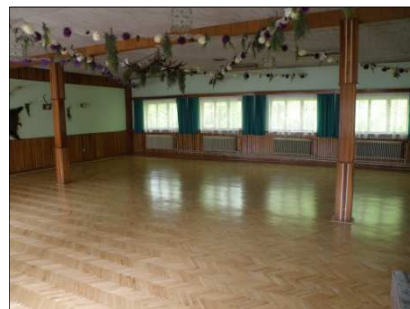
Oprava parket v Hájence
