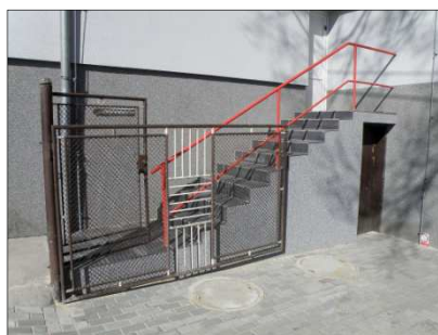
Rekonstrukce vstupu u HZ
