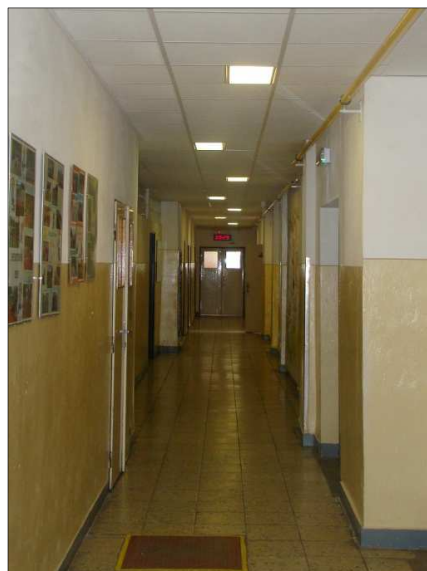
Nové elektrorozvody v budově ZŠ
