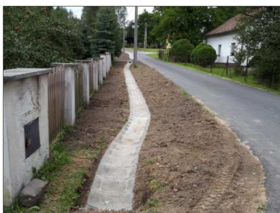
Odvodnění komunikace na Zálesí
