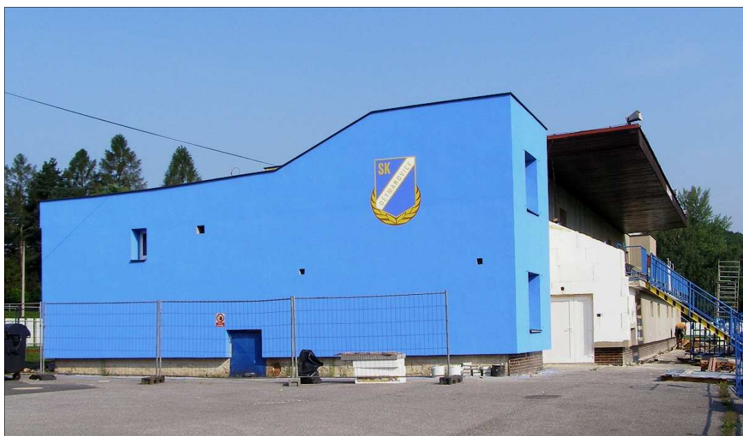
Nová fasáda na budově SK
