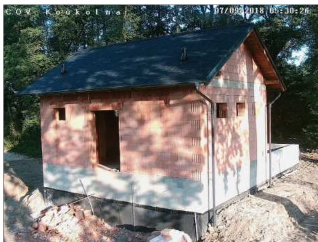
Stavba kanalizace Koukolná
