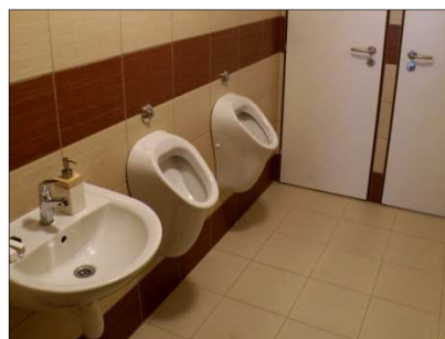
Rekonstrukce WC v hájence
