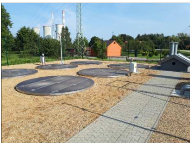
Stavba kanalizace ZŠ + Šlog – 2. etapa
