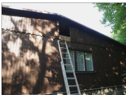
Zateplení stropu v hájence
