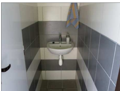
Rekonstrukce WC na hřbitově
