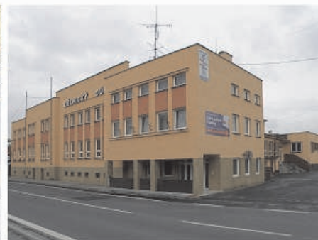
Obnova fasády Dělnického domu
