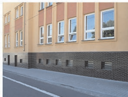
Oprava soklu Dělnického domu
