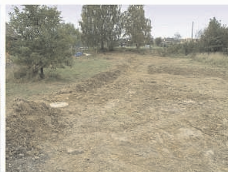
Odvodnění pozemku na Olmovci
