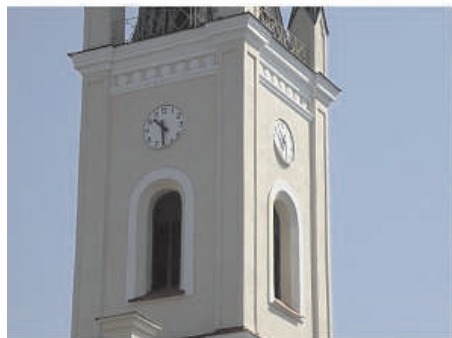
Oprava fasády věže kostela
