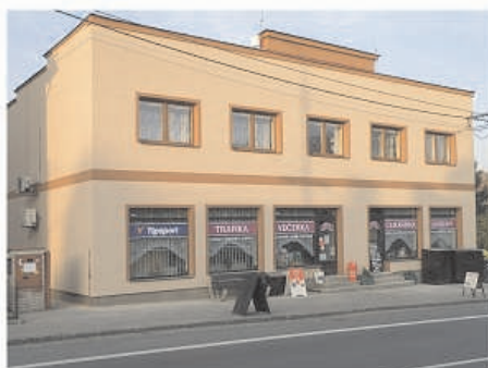
Zateplení budovy čp. 942
