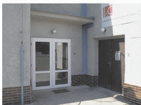
Výměna dveří v budově SK
