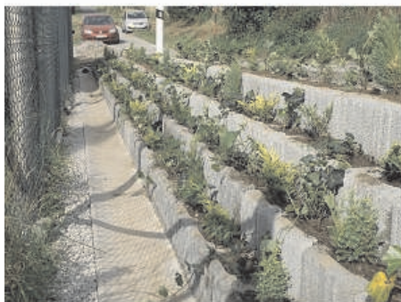
Opěrná zeď Ryšková
