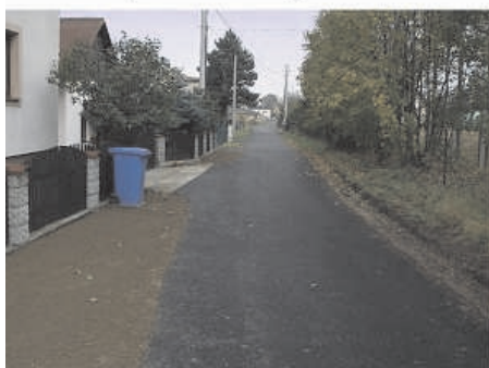
Místní komunikace Ulman - Balon
