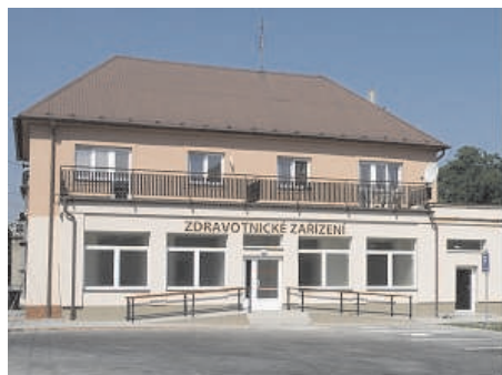
Stavební úpravy čp. 900
