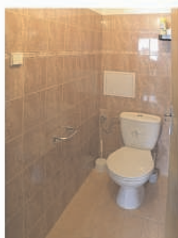
Nové rozvody vody v DPS
