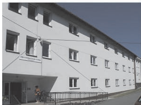
Výměna oken v DPS u Lutyně
