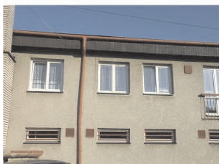
Výměna oken v budově SK
