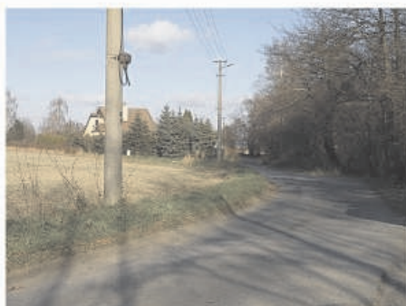
Odvodnění komunikace směr Zálesí
