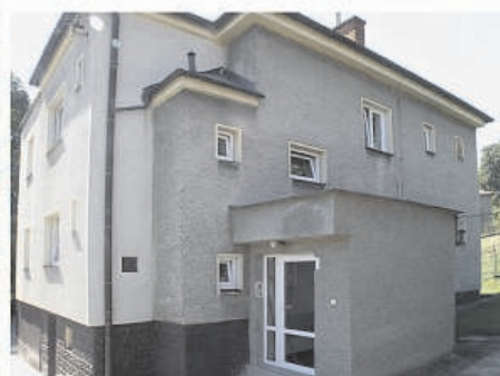
Výměna oken a dveří v DPS
