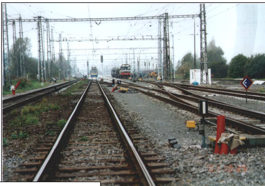
Pohled na rekonstrukci trati z míst, kde stála bývalá železniční zastávka Koukolná
