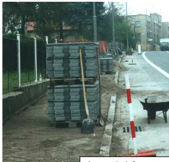
Oprava chodníku směrem k Dělnickému domu. Foto D. Šnapková
