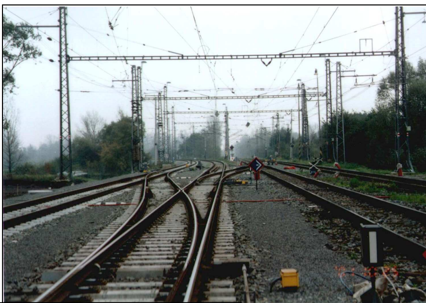
Pohled na rekonstrukci trati z míst bývalé zastávky Koukolná. Vlevo trať směrem na Petrovice, vpravo do Karviné
