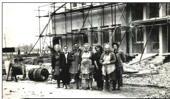
Snímek z výstavby nové nádražní budovy
