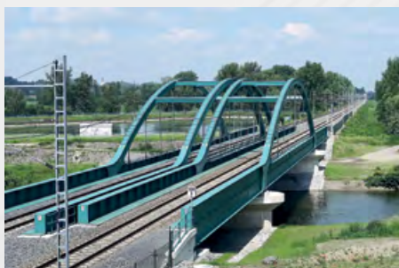
Pohled ze silničního mostu.
