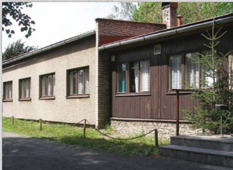
^ V hájence byla v posledních letech provedena rekonstrukce sociálního zařízení, zateplení půdy, oprava podlahy v sále. Také nevyhovující kuchyně doznala změn.
