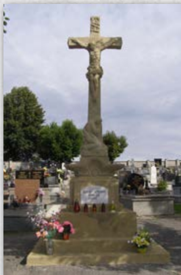
^ Kříž v centrální části hřbitova po opravě.
