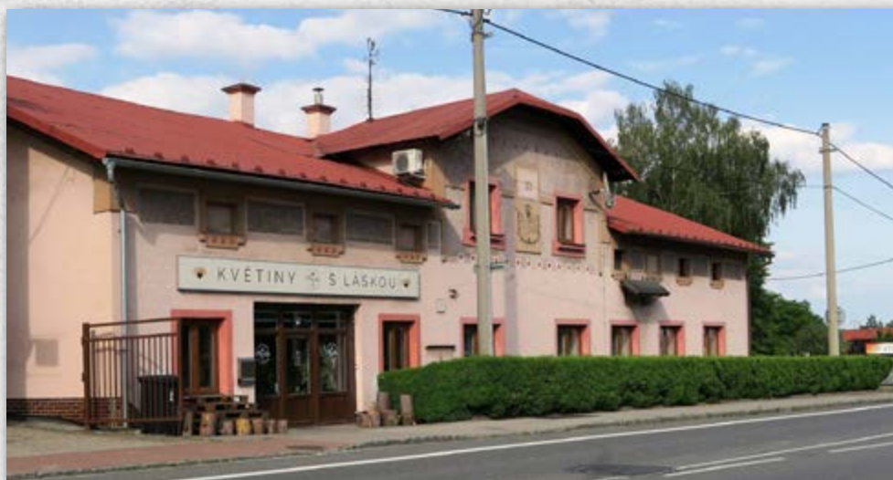
^ Dům samotný patří mezi nejstarší objekty v obci a prožil už toho hodně. Z historie stojí za připomenutí zmínka o prosperující hospodě či o loutkovém divadle. Má obytnou část a prostory pro podnikání. V současné době je zde prodejna květin, která se svým stylovým interiérem k tomuto objektu velmi hodí.
