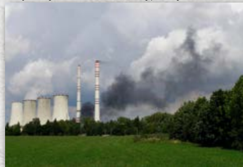
^ Požár elektrárny v roce 2017.
