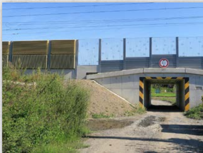
^ Současně s rekonstrukcí koridoru byly v Koukolné instalovány hlukové zábrany. Nový podjezd k domkům za železniční tratí.
