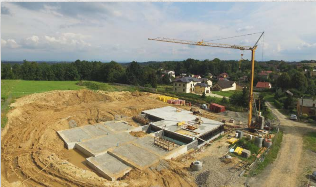
^ V červenci 2020 byly hotovy základy a začínalo se stavět.
