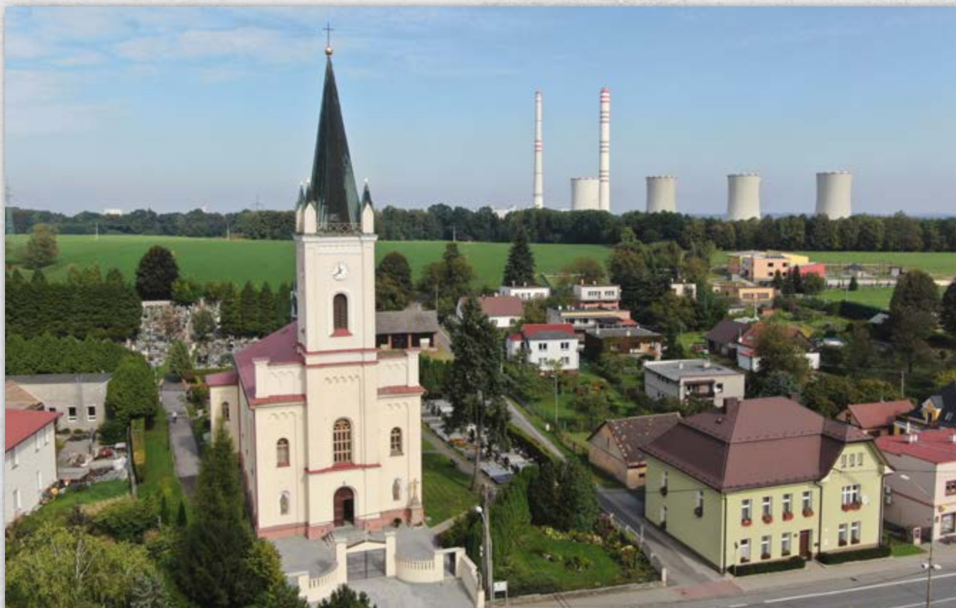
^ Dvě dominanty obce - kostel a elektrárna. V kostele byla v roce 2022 provedena rekonstrukce elektrorozvodů a následně vymalování. Celkové náklady si vyžádaly částku 1,5 milionu Kč. Obec přispěla částkou 500 tisíc Kč.
