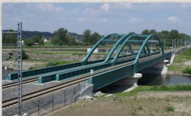
^ Pohled na nový most ze silničního nadjezdu na Závadu.
