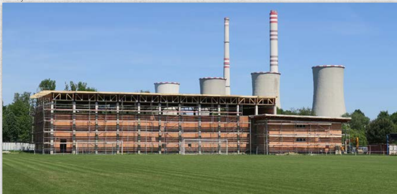
^ Výstavba sportovní haly - stav 20. května 2022.
