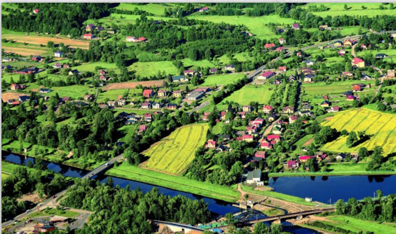
^ Koukolná na levém břehu řeky. Vlevo most přes Olši a příjezdová komunikace od Karviné, vpravo dole železniční most v době rekonstrukce v roce 2018.
