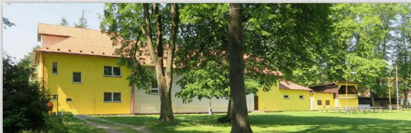
^ V roce 2022 byla provedena oprava fasády na všech stavbách sokolského areálu.
