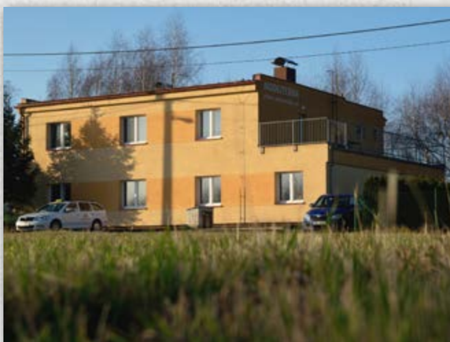
^ Modlitebnu stále zvelebují. Během roku 2011 proběhla rozsáhlá oprava budovy. Byla vyměněna okna, zatepleny vnější stěny a zhotovena nová fasáda.
