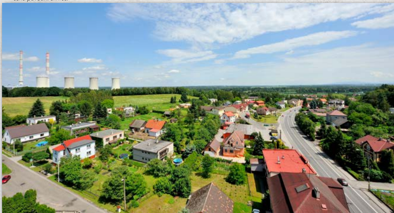
^ Barevná fotografie z jiného úhlu pořízená při opravě fasády kostela v roce 2012. Vpravo dole jsou vidět střechy fary a knihovny.
