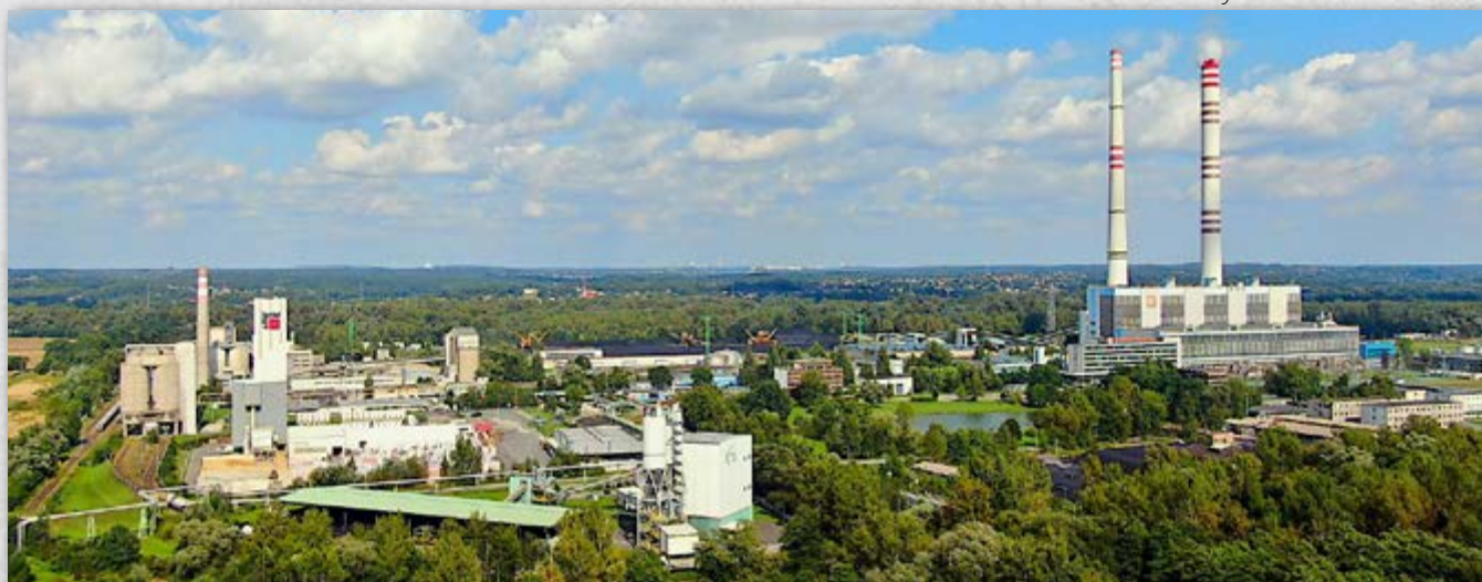
^ Pohled z dronu na celou průmyslovou zónu u elektrárny, vlevo úplně v popředí Coal Mill, za ním Baumit a úplně vzadu Cemex.
