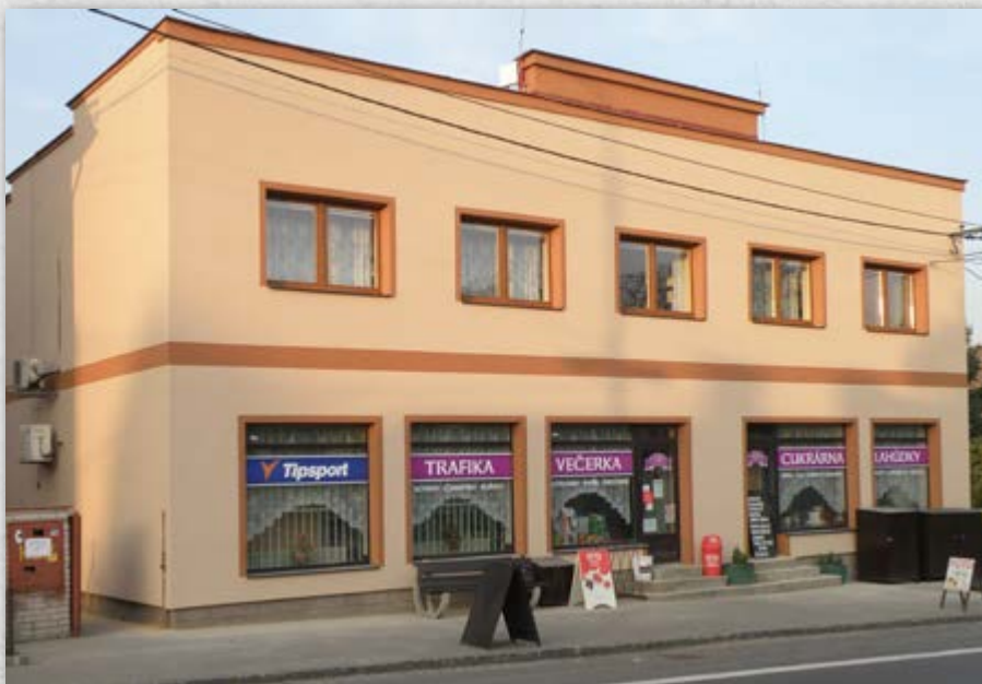
^ V roce 2006 byla v knihovně instalována nová plastová okna, v roce 2011 provedeno zateplení budovy.
