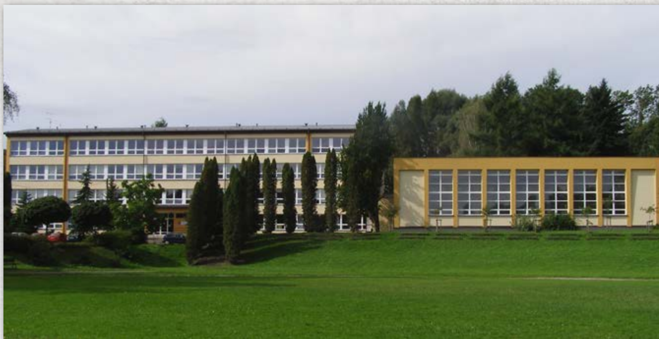
^ Hlavní budova a tělocvična po rekonstrukci.
