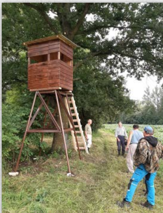
^ Po honitbě mají myslivci rozmístěny jednoduché posedy i krásné kazatelny. Na snímku stavba nové v Lyngu v roce 2020.
