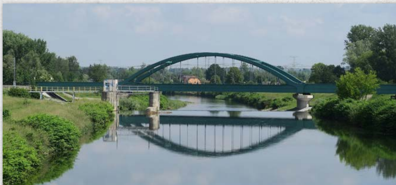
^ Nový most byl postaven v letech 2018–2019. Pro každou kolej stojí samostatná konstrukce, její celková délka je 121 metr. Tato stavba získala na mezinárodním sympoziu v Praze prestižní ocenění „Mostní dílo“ jako jedna ze čtyř oceněných.
