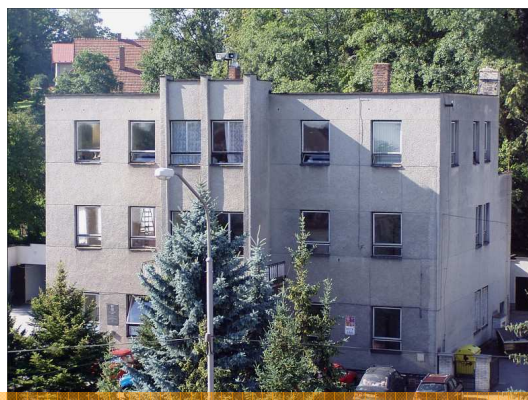
Jedna z úplně posledních fotografií budovy čp. 27 před rekonstrukcí v roce 2003.
