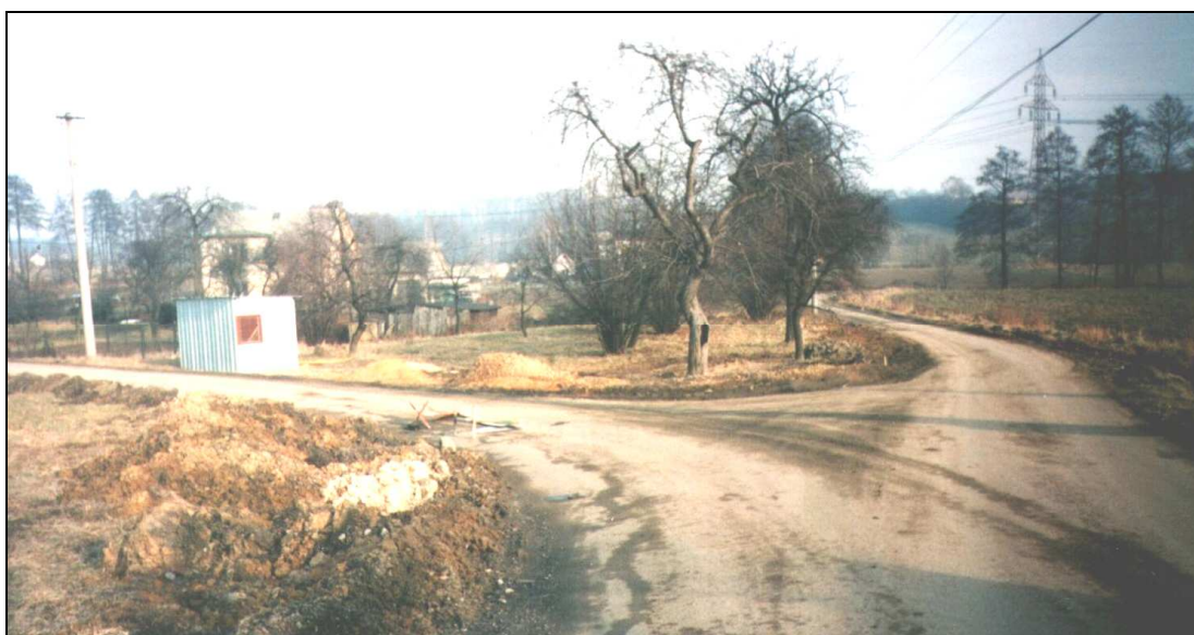
Dokončovací práce na plynovodu „P 5“ na Zálesí v lednu 1999
