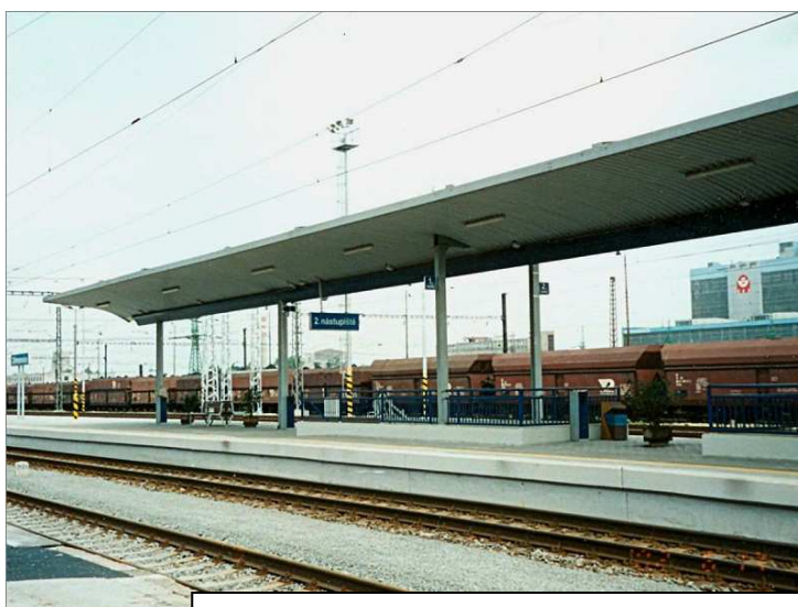
Dva záběry na rekonstruované železniční nástupiště v Dětmarovicích.
