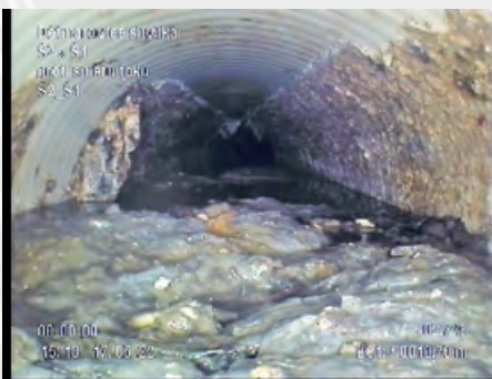
Částečně ucpané potrubí směsí hygienických pomůcek (vlhčené ubrousky apod.).
