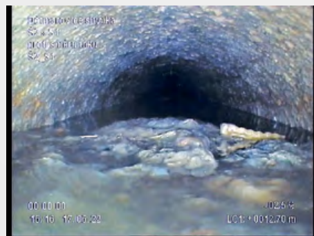
Částečně ucpané potrubí směsí hygienických pomůcek (vlhčené ubrousky apod.).
