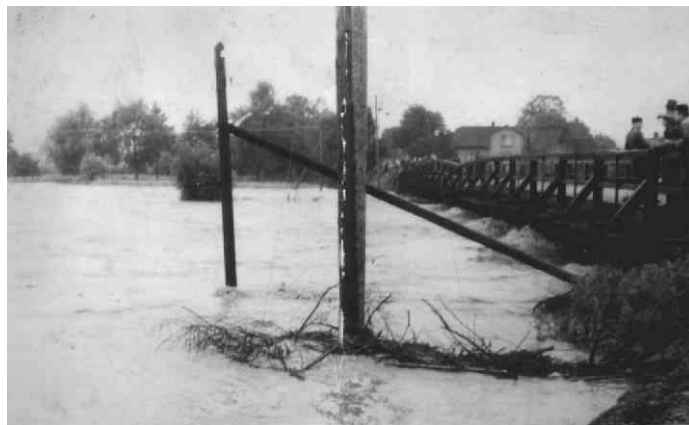
Povodeň na Olši u starého silničního mostu v Koukolné v roce 1940
