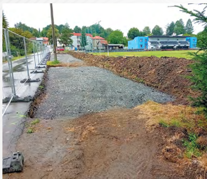
Stavba parkoviště SK.
