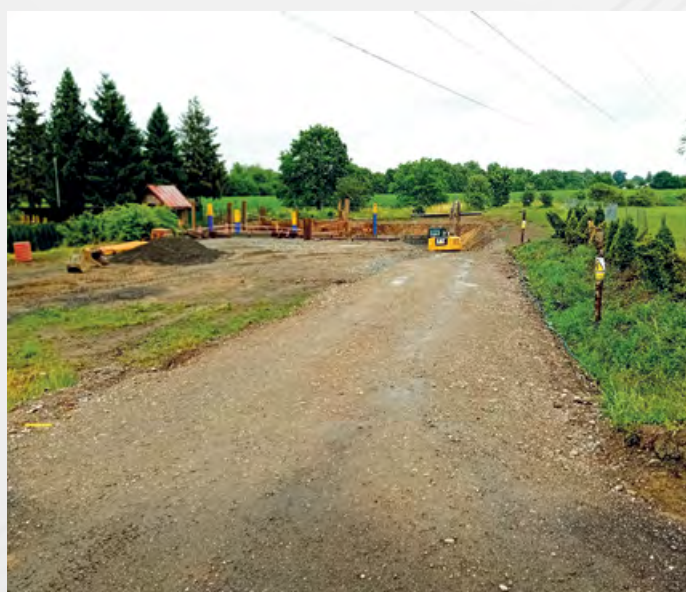
3. etapa kanalizace – zahájení prací.
