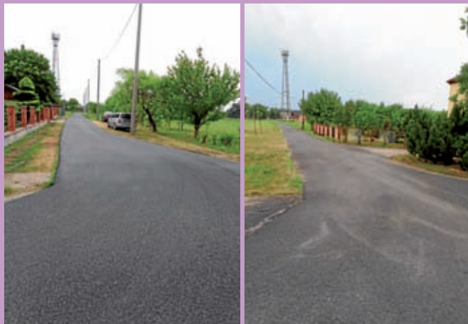
Oprava komunikace v Koukolné zástřikem
