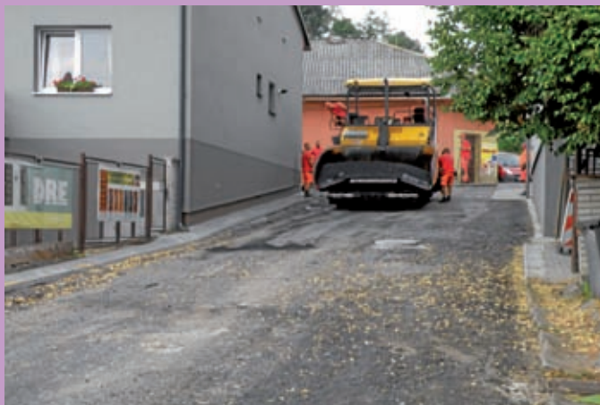
Plošná oprava komunikace k Sokolovně
