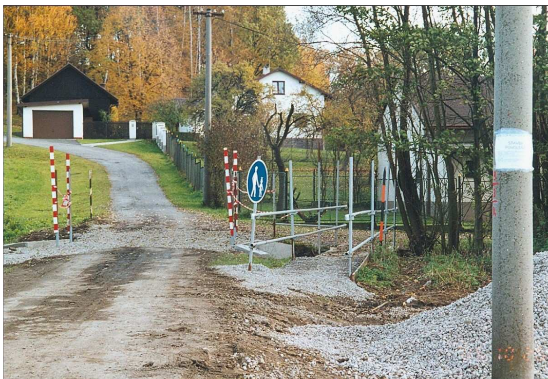
Stavba mostku na Zálesí u domu čp. 376 pod Wilczkovým kopcem
