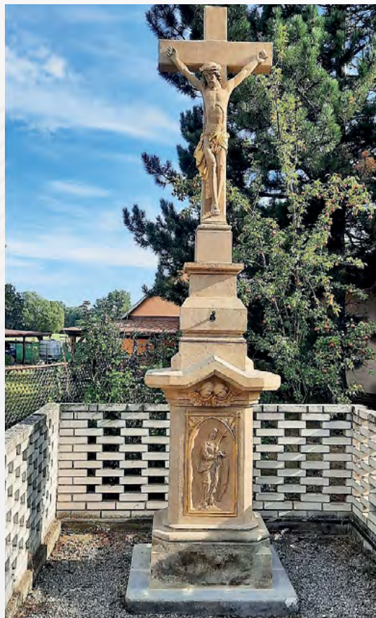
Oprava kříže v Koukolné.
