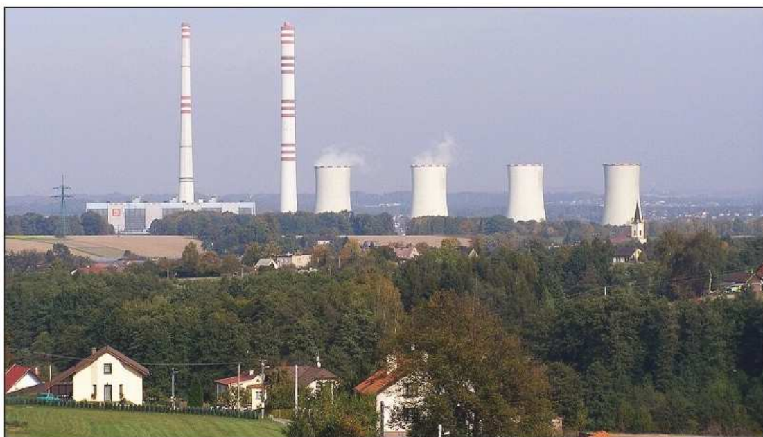
Pohled na elektrárnu z 5. patra domu na 5. etapě v Orlové – Lutyni.
