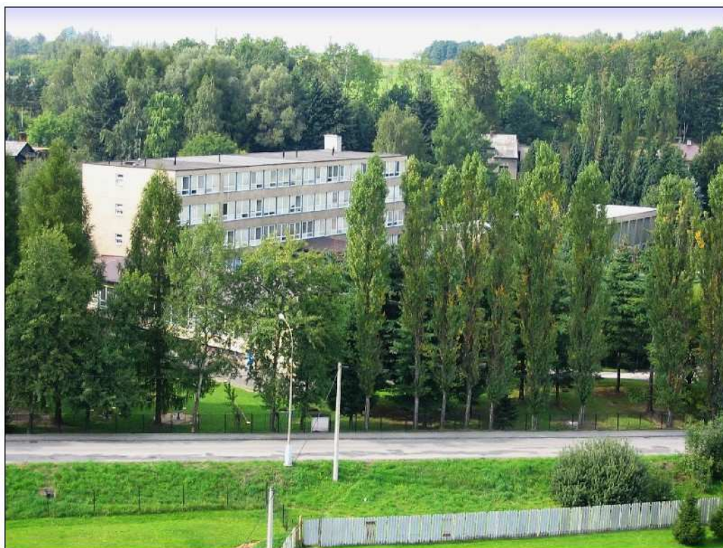
Pohled na areál základní školy – opět z plošiny požárního vozu.
