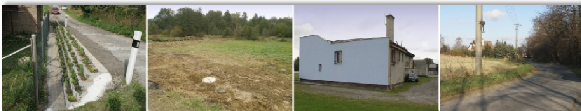
Opěrná zeď Ryšková, parcela č. 1200, budova SK, odvodnění na Zarembově cestě.
