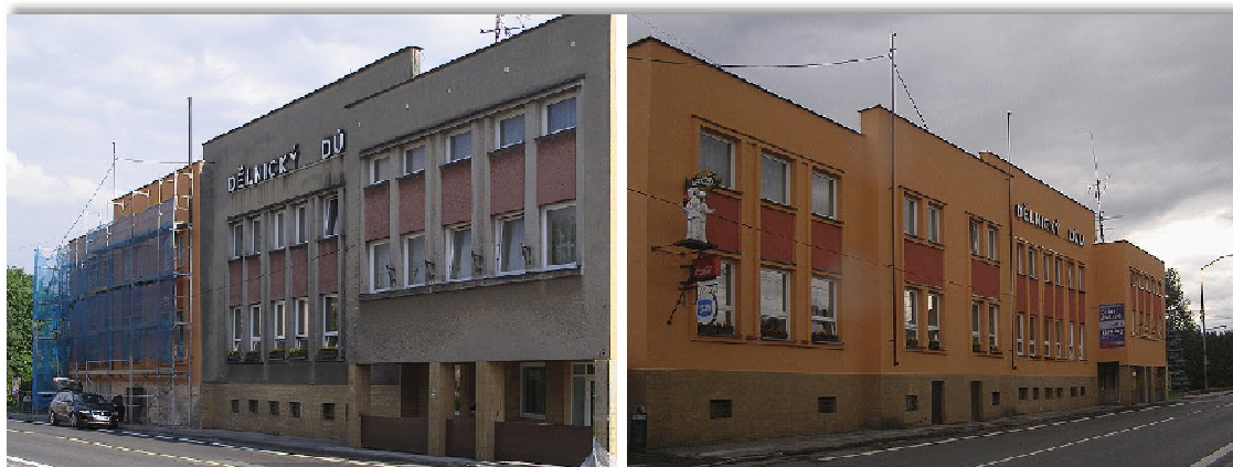
Nátěr fasády na Dělnickém domě proveden v rámci údržby budov.
