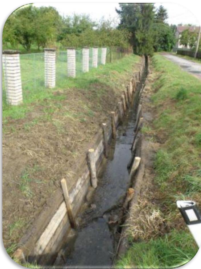
Provedení opravy břehů Hraničního potoka, plůtkování
