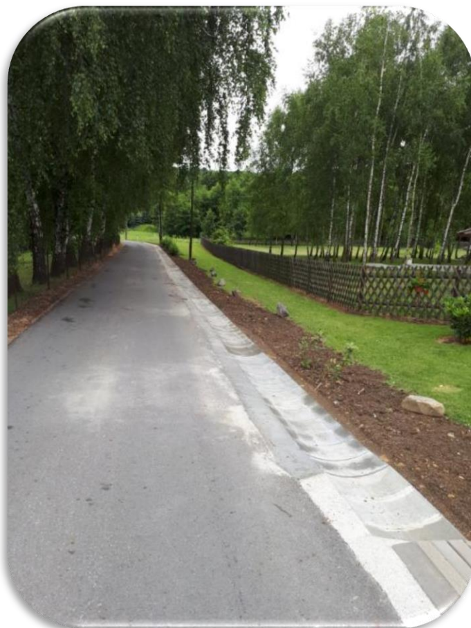
Pokračování odvodnění komunikace na Zálesí
