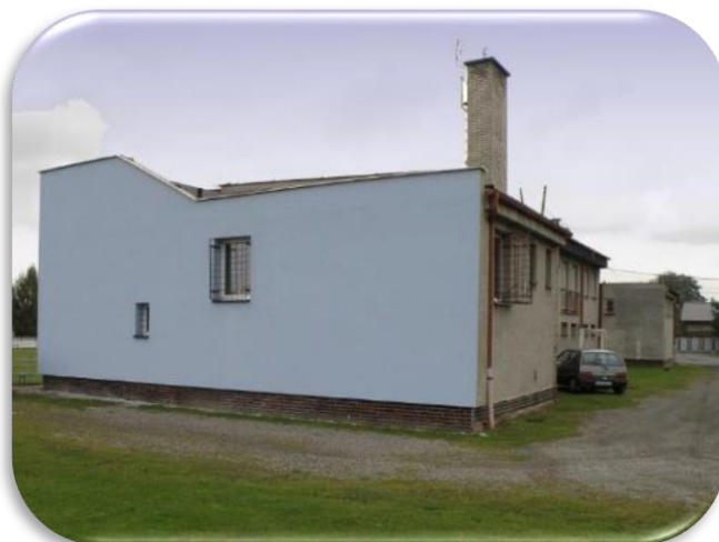
Výměna oken a částečné zateplení budovy SK.
