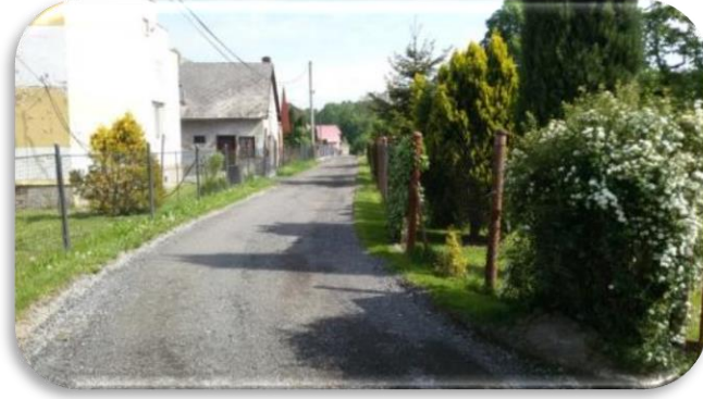
Nové povrchy zhutněným recyklátem – 2 komunikace na Zálesí
