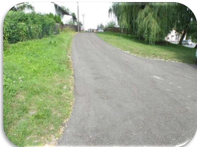
Plošné opravy místních komunikací návozem recyklátu, jeho rozprostřením a zhutněním (zaválcováním) u č.p.60
