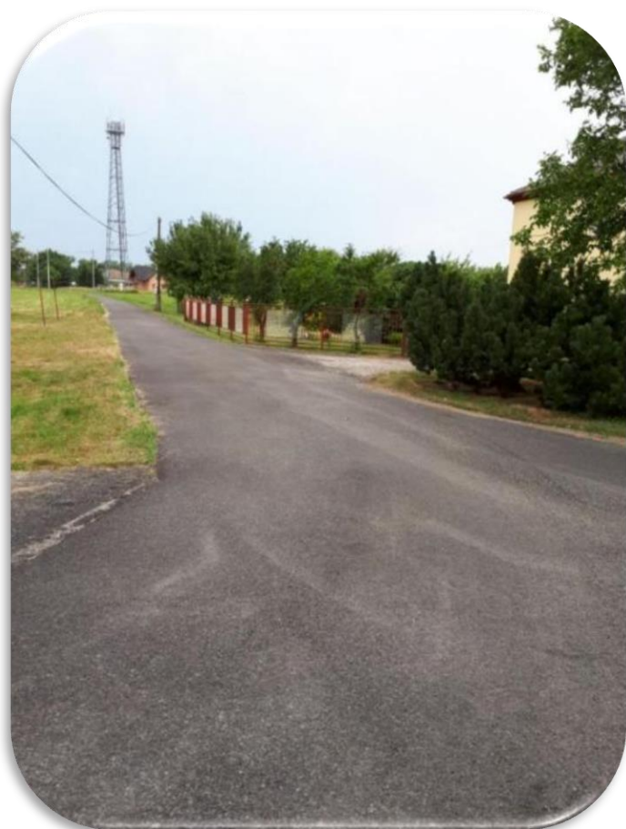
Oprava komunikace v Koukolné zástřikem
