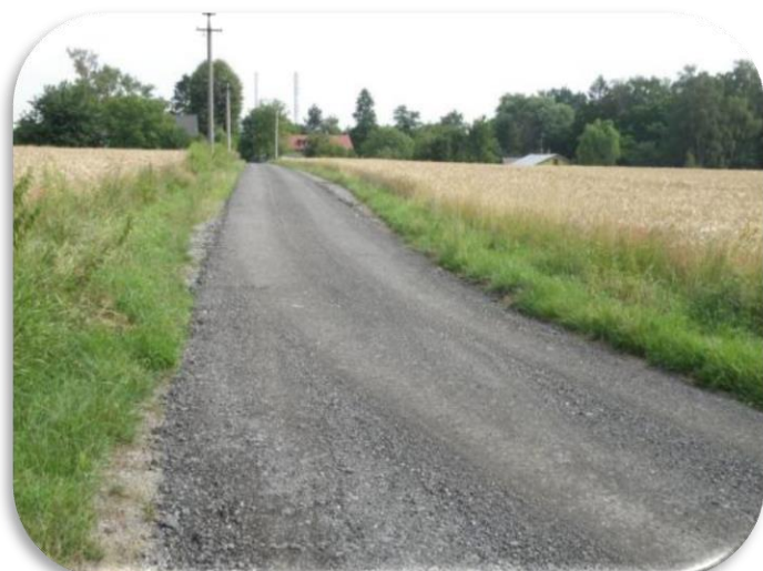
Plošné opravy místních komunikací návozem recyklátu ,jeho rozprostřením a zhutněním (zaválcováním) u č.p.340
