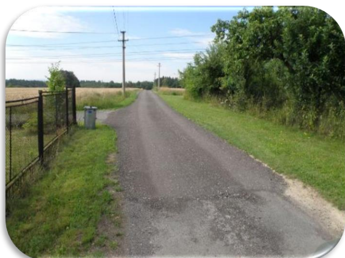
Plošné opravy místních komunikací návozem recyklátu ,jeho rozprostřením a zhutněním (zaválcováním) u č.p.340
