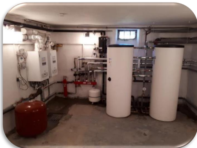
Modernizace zdroje tepla na DPS vč. solárního ohřevu
