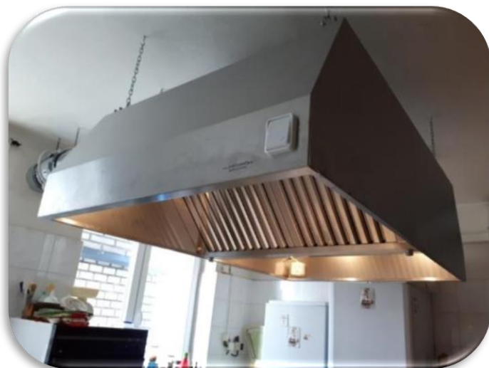
Instalace digestoře v kuchyni na SK
