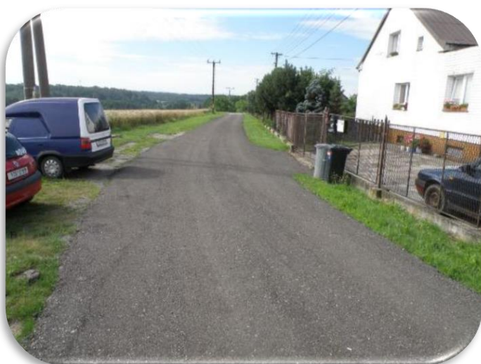
Plošné opravy místních komunikací návazem recyklátu ,jeho rozprostřením a zhutněním (zaválcováním) u č.p.315
