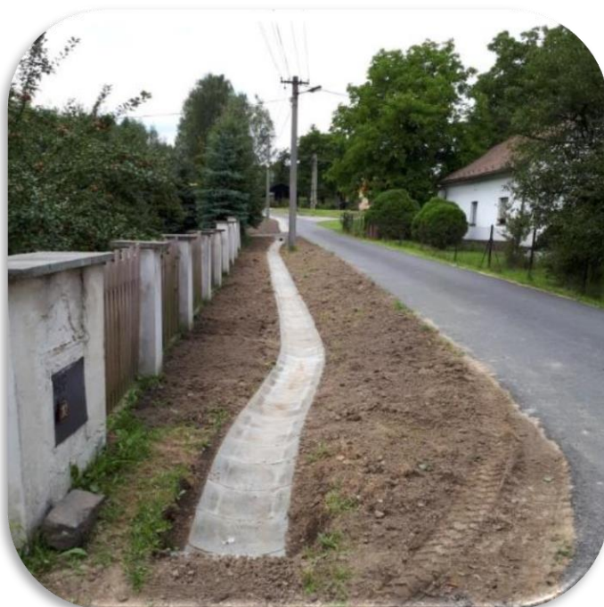
Odvodnění komunikace (položení žlabů) na Zálesí.
