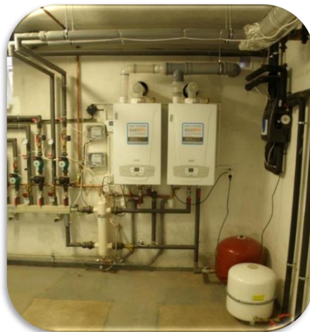
Rekonstrukce plynové kotelny v budově čp. 1120 – SK Dětmárovice
