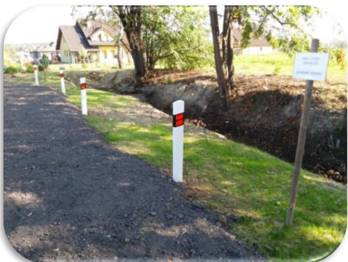
Odvodnění komunikace nad Dělnickým domem
