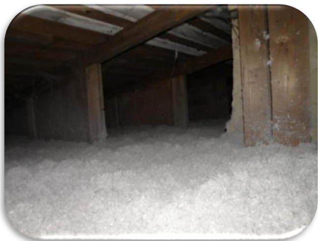
Zateplení půdy Hájenky – foukaná izolace
