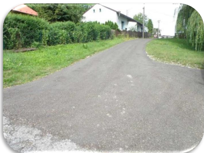
Plošné opravy místních komunikací návozem recyklátu, jeho rozprostřením a zhutněním (zaválcováním) u č.p.60
