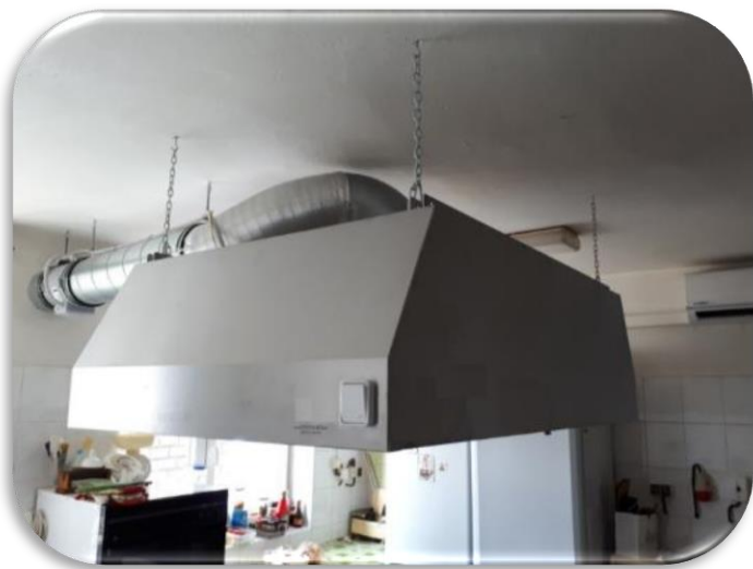
Instalace digestoře v kuchyni na SK
