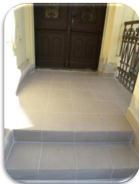
Oprava venkovních schodů na poštu
