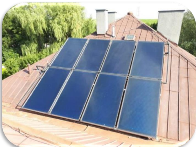
Modernizace zdroje tepla na DPS vč. solárního ohřevu
