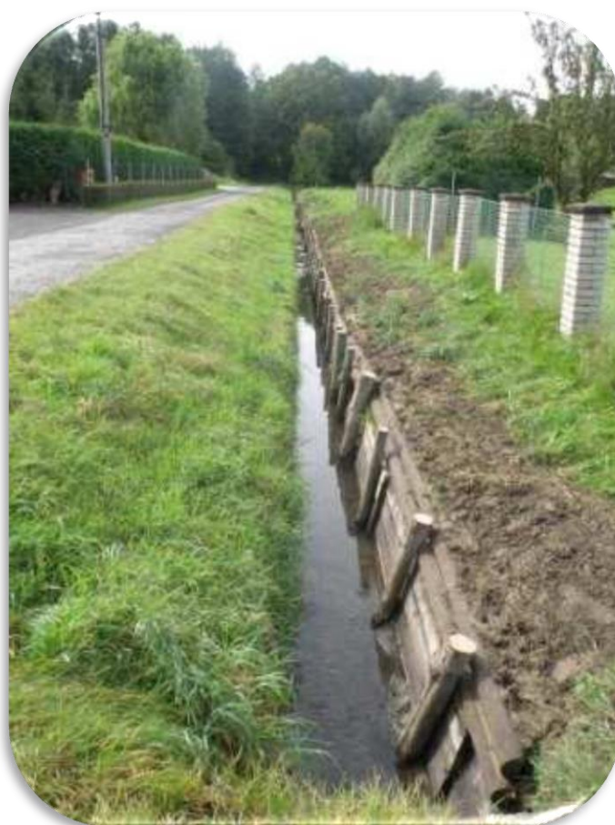
Provedení opravy břehů Hraničního potoka, plůtkování
