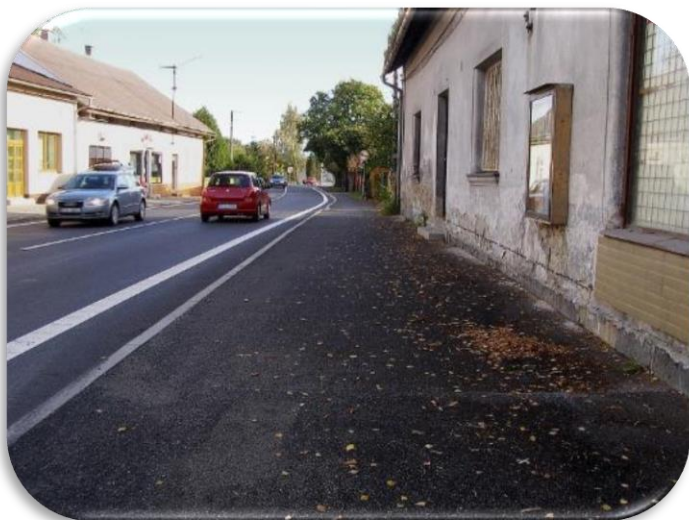
Obnova obrubníků a chodníku u hlavní silnice
