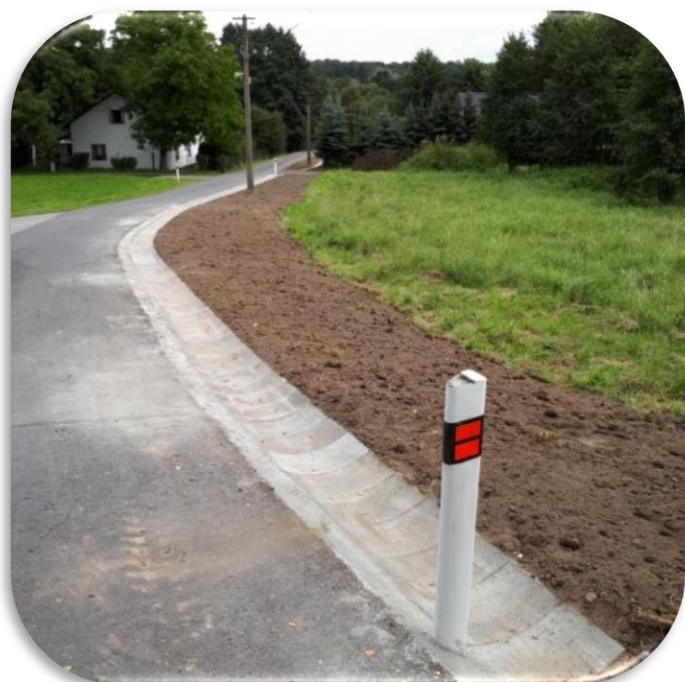
Odvodnění komunikace (položení žlabů) na Zálesí.
