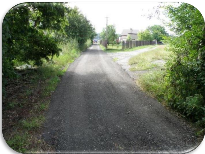
Plošné opravy místních komunikací návazem recyklátu ,jeho rozprostřením a zhutněním (zaválcováním) u č.p.315
