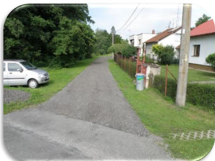
Plošné opravy místních komunikací návozem recyklátu ,jeho rozprostřením a zhutněním (zaválcováním) u č.p.639
