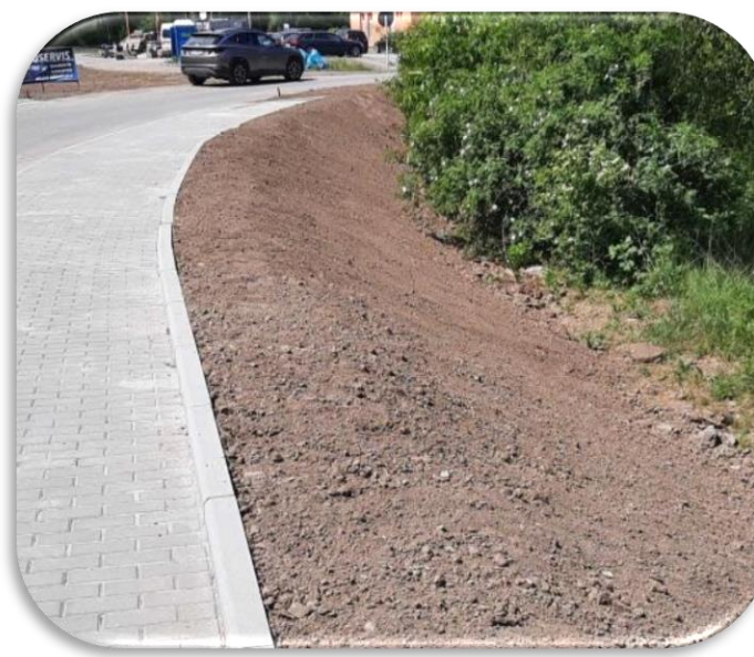
Chodník u silnice I/67 v Koukolné – část 4
