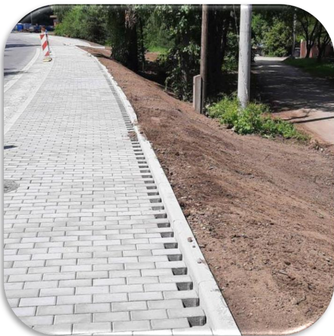
Chodník u silnice I/67 v Koukolné – část 5
