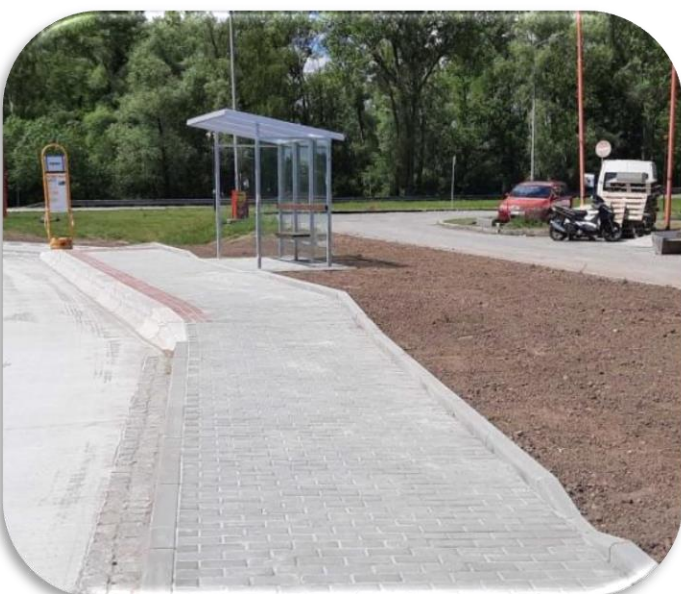
Chodník u silnice I/67 v Koukolné – část 3
